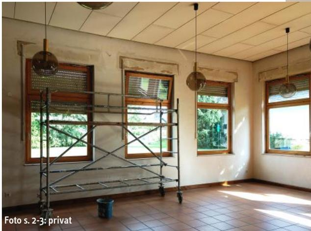
Seit Anfang August laufen nun die Arbeiten im Saal. Die Bilder dokumentieren weiteren Einsatz der Helfer: Tapete wurde entfernt, Zustand und Tragfähigkeit der Decke geprüft, die Tür zum Lagerraum entfernt - hier soll der Eingang verbreitert werden, um besser Tische
